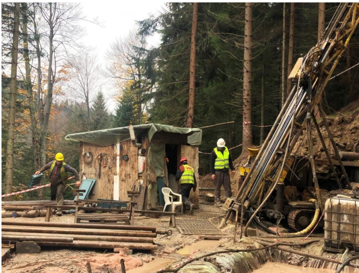
Fotografija 5.11.2 Oprema za bušenje u šumskom predjelu Rupice
