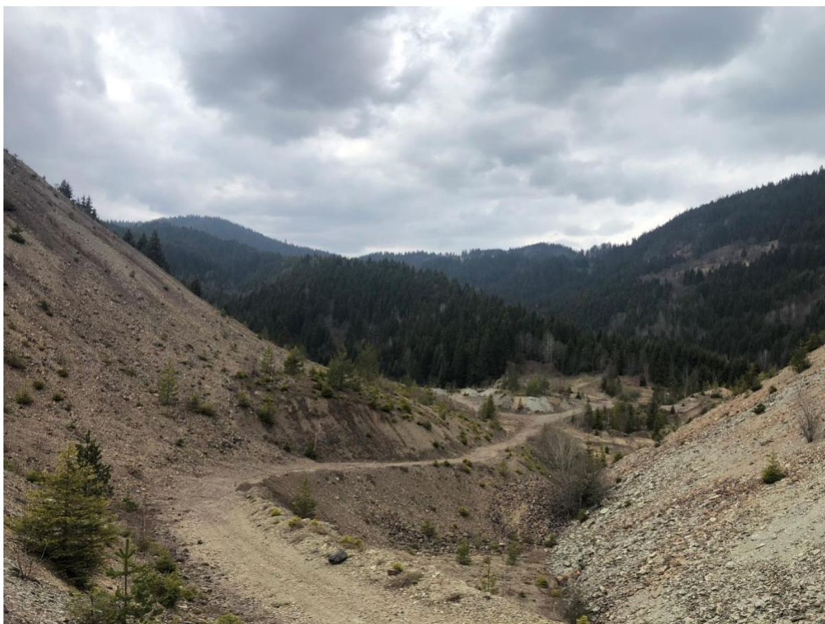
Fotografija 5.11.3 Područje ranijeg rudnika, zapadno od Vareša gdje će se izgraditi dionica transportnog puta
