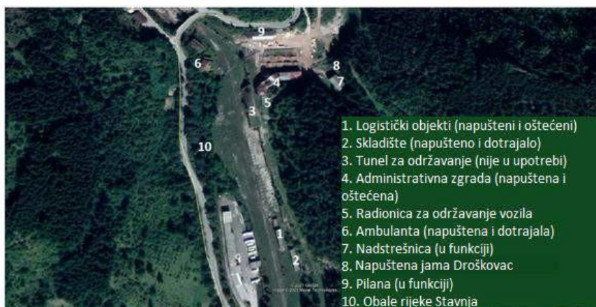
Prikaz 4.5.7: Pregledane zgrade na transfer stanici Droškovac, Vareš.
